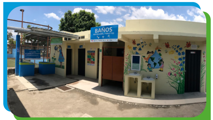
Módulo Sanitario en Centro de Descanso Temporal Carlos Roberto Reina, Trojes.
